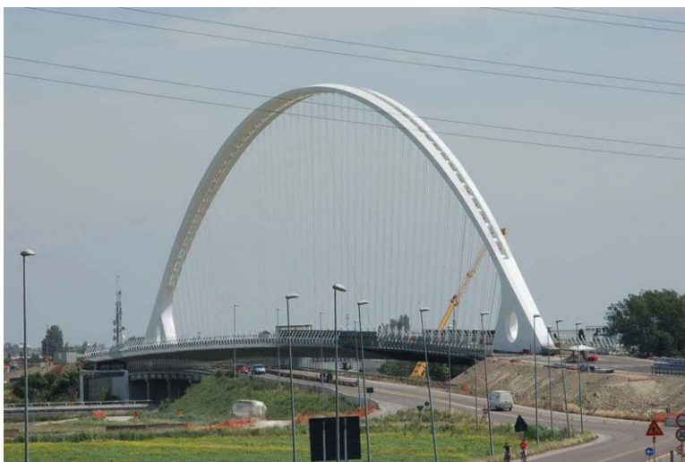
Uno dei ponti di Santiago Calatrava a Reggio.
